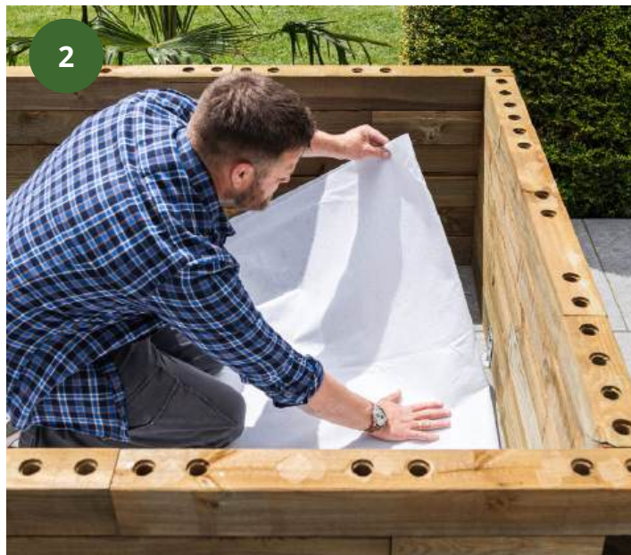
Ajout d'une protection de sol – utilisez une thibaude, un morceau de moquette ou un tissu géotextile pour éviter de percer la bâche sans le vouloir.
