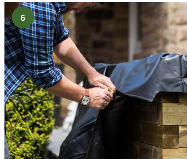
Découpage d'une partie de la bâche en trop – pour mieux l'ajuster, découpez soigneusement une partie de la bâche qui dépasse sur les bords (laissez tout de même dépasser une bonne largeur).
