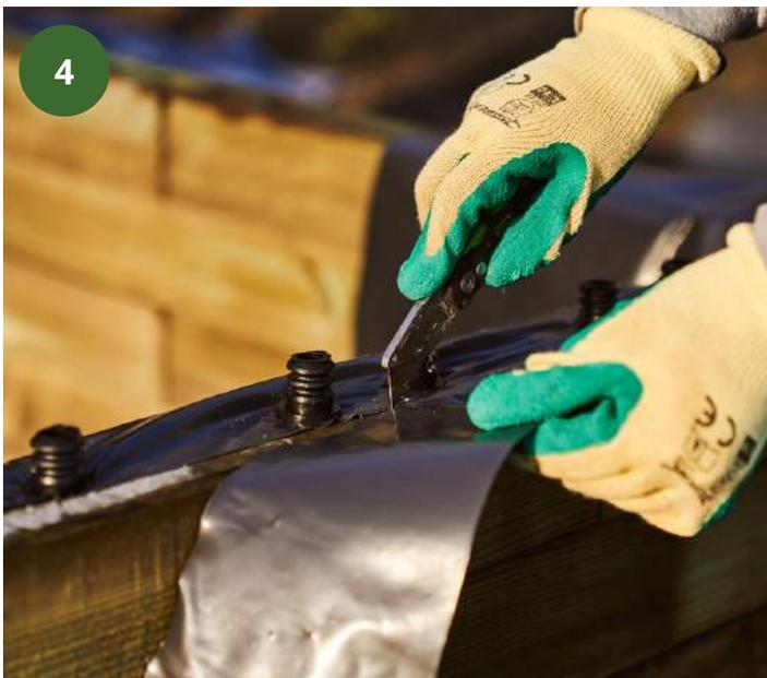
**Coupez l'excédent de bâche au cutter** – au moyen d'un cutter, découpez soigneusement la bâche qui dépasse entre le dernier niveau et le rebord.
